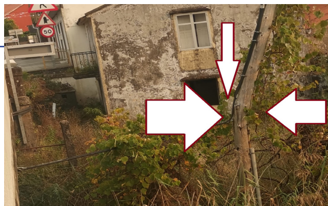
Só a ancoraxe no muro da entrada da ponte é o que aínda sustenta este poste de Telefónica na Ponte Nafonso.
